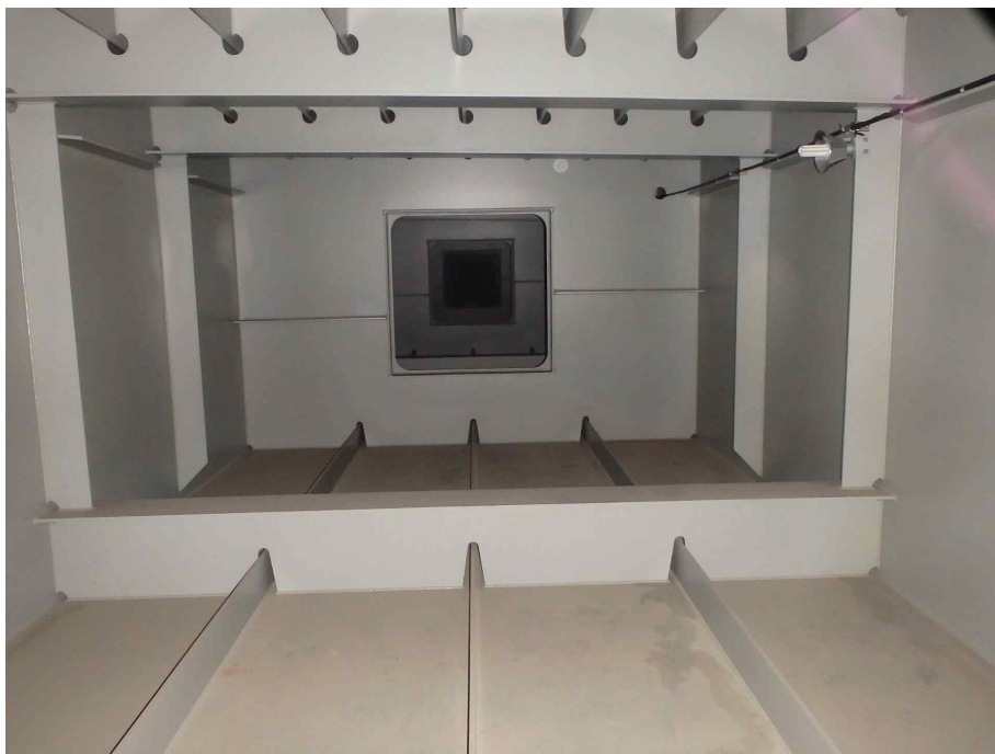
Steel Box Girder 내부 전경
