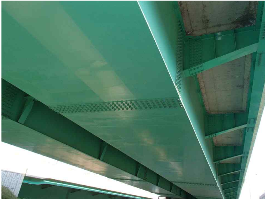
Steel Box Girder 외부 전경
